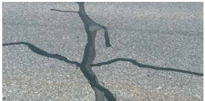
Risse in der Fahrbahn mit Triflex ReproFix RS 2K repariert.
