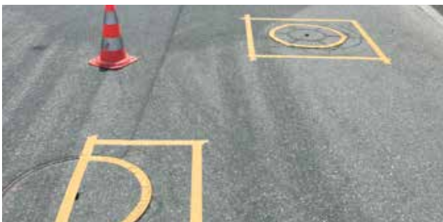
Angleichen von Schachtabdeckungen...
