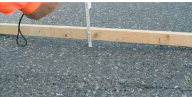
Schnelle und einfache Sanierung von Spurrillen...
