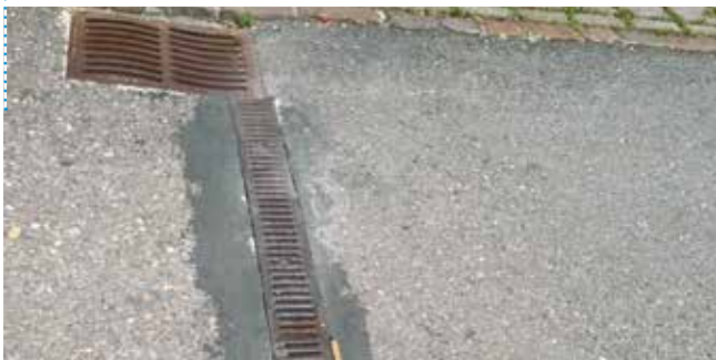
Nachhaltige Sanierung von Wasserrinnen...
