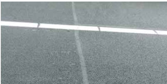
Fahrbahnfugen mit Triflex ReproFix RS 2K gefüllt.
