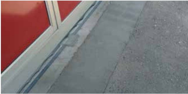
Triflex Cryl RS 240 für Anrampungen im Betonbereich.
