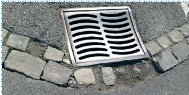
Sanierung von Wassersteinen...
